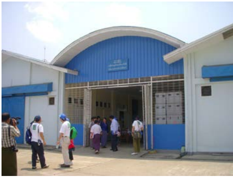
コールドルームの外観(ヤンゴン)
